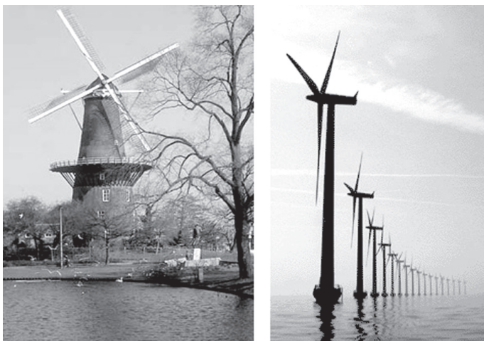
Рис. 39. Старинная мельница и парк современных ветроэлектростанций, каждая из которых, обладая мощностью 1 МВт, способна удовлетворить бытовые потребности в электричестве 750 семей
