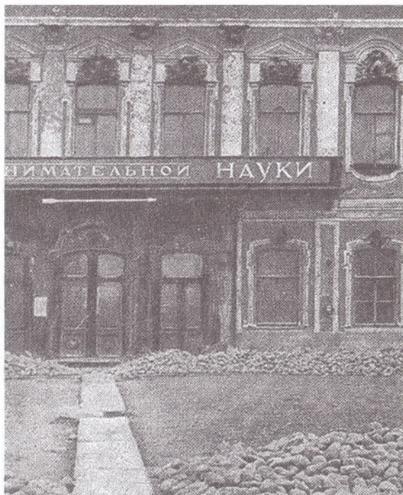
Ремонт мостовой у входа в ДЗН. Белая дорожка – это «собственный» ДЗНовский меридиан. (Снято в 1936 г.).
